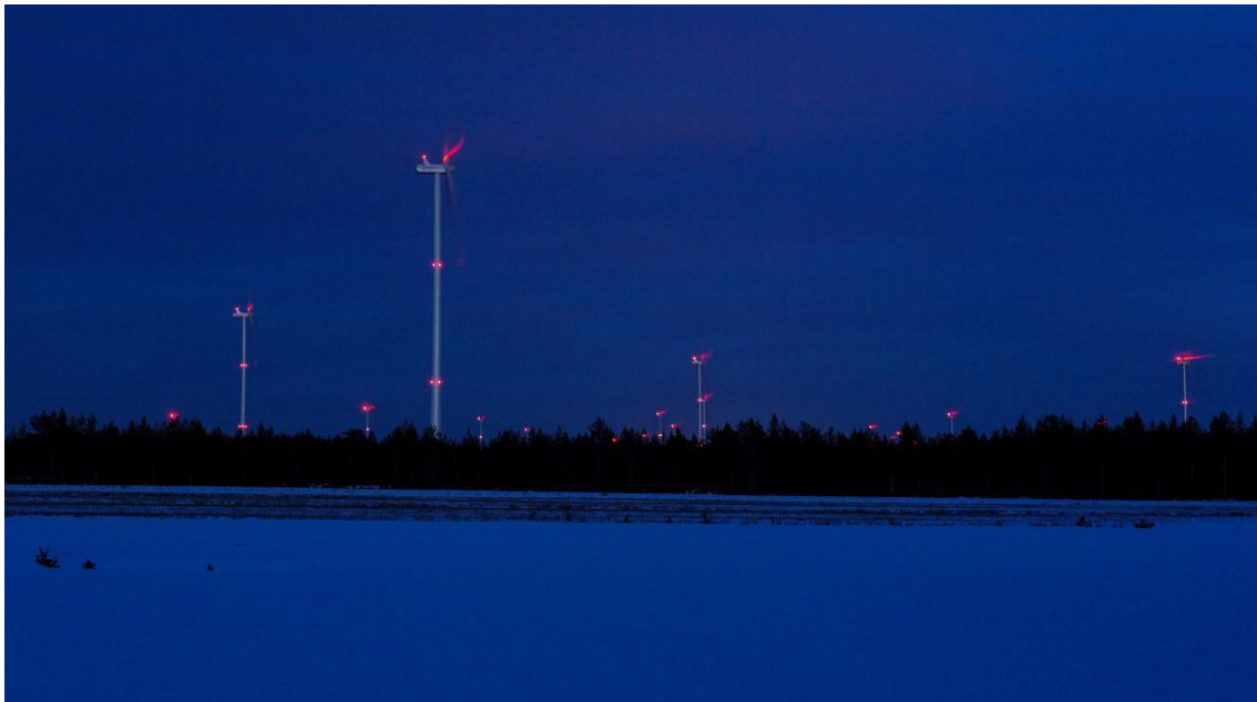
Kuva 94. Kiinteät punaiset lentoestevalot (FCG Finnish Consulting Group Oy).
