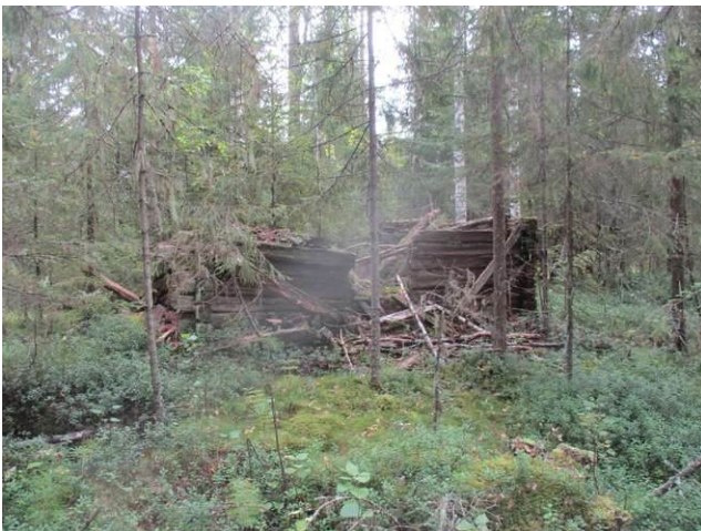
Alakohde 3-4. Hirsirakennuksen jäännös.
