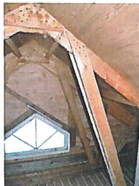
Vasemmalla alkuperäinen hirsiseinä, jonka ulkopuolelle lisäeristys, muha / villa n. 10 cm ja vanha ulkoverhouslaudoitus, jonka päälle koolaus n. 5 cm ja tuulensuojalevy sekä ulkoverhous. Lisäksi kuvia ullakkotilasta.
