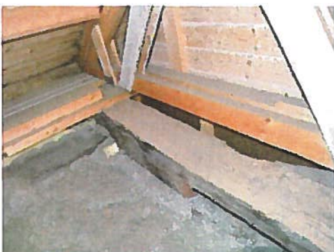
Vasemmalla alkuperäinen hirsiseinä, jonka ulkopuolelle lisäeristys, muha / villa n. 10 cm ja vanha ulkoverhouslaudoitus, jonka päälle koolaus n. 5 cm ja tuulensuojalevy sekä ulkoverhous. Lisäksi kuvia ullakkotilasta.
