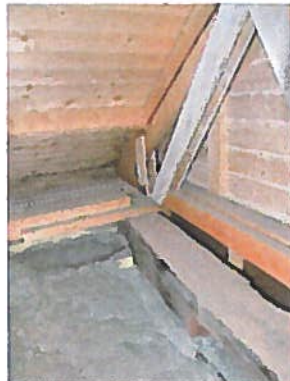
Vasemmalla alkuperäinen hirsiseinä, jonka ulkopuolelle lisäeristys, muha / villa n. 10 cm ja vanha ulkoverhouslaudoitus, jonka päälle koolaus n. 5 cm ja tuulensuojalevy sekä ulkoverhous. Lisäksi kuvia ullakkotilasta.
