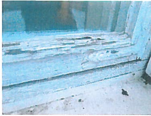
Ikkunapieli sekä ikkunapielissä paikoin pinnoitteen hilseilyä / alkavaa lahovikaa.
