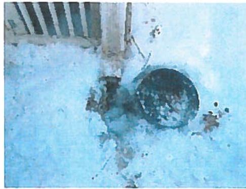
Sadevesien poistot osittain puutteelliset, (sadevesikaivot asennettu osittain).
