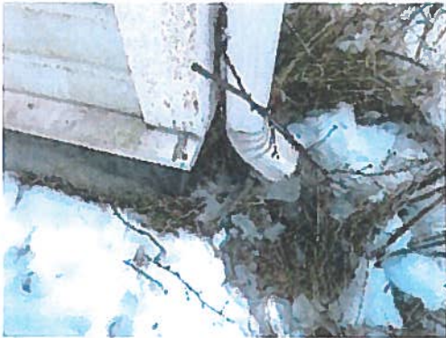
Sadevesien poistot osittain puutteelliset, (sadevesikaivot asennettu osittain).
